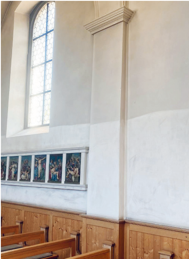
Dieses Bild zeigt den Kontrast, nachdem ein Teil der Wand in einem ersten Durchgang gereinigt wurde.
