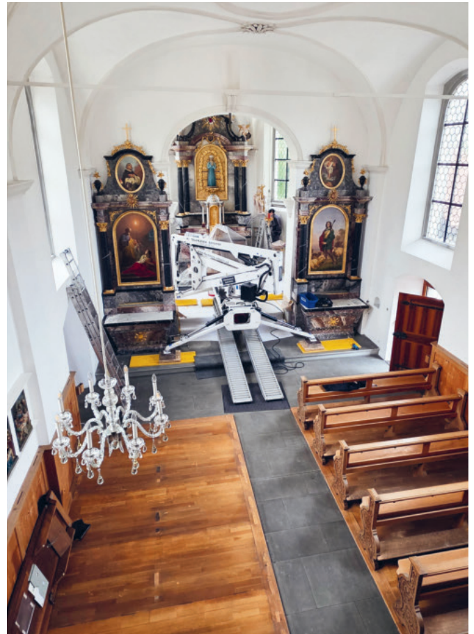
Eine Impression, kurz vor dem Abschluss der Arbeiten.
