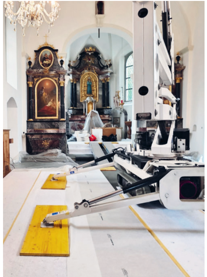
Die Hebebühne ermöglichte die sichere Arbeit ohne Baugerüst.
